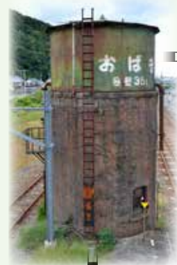
◀小浜駅のホーム端にたたずむ給水塔
