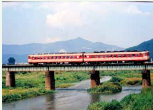
(昭和 63 年 9 月撮影・南川鉄橋)
