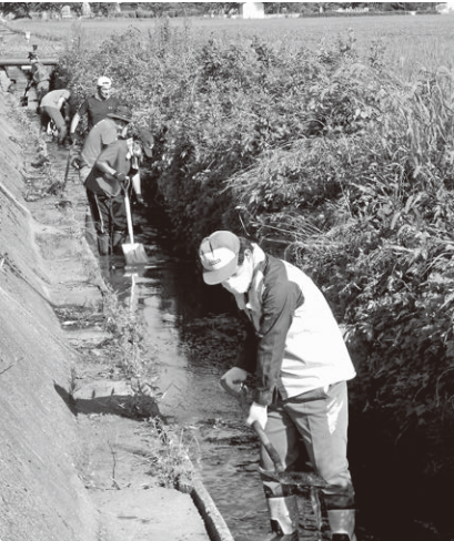
水路の泥上げ作業の様子（高塚）
